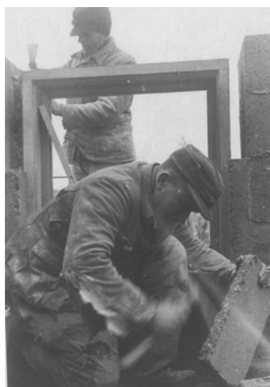
Reportaż z budowy eksperymentalnych domków gruzobetonowych Instytutu Badań Budownictwa na Polu Mokotowskim, 1948, Socjalistyczna Agencja Prasowa, NAC
