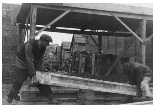
Reportaż z budowy eksperymentalnych domków gruzobetonowych Instytutu Badań Budownictwa na Polu Mokotowskim, 1948, Socjalistyczna Agencja Prasowa, NAC
