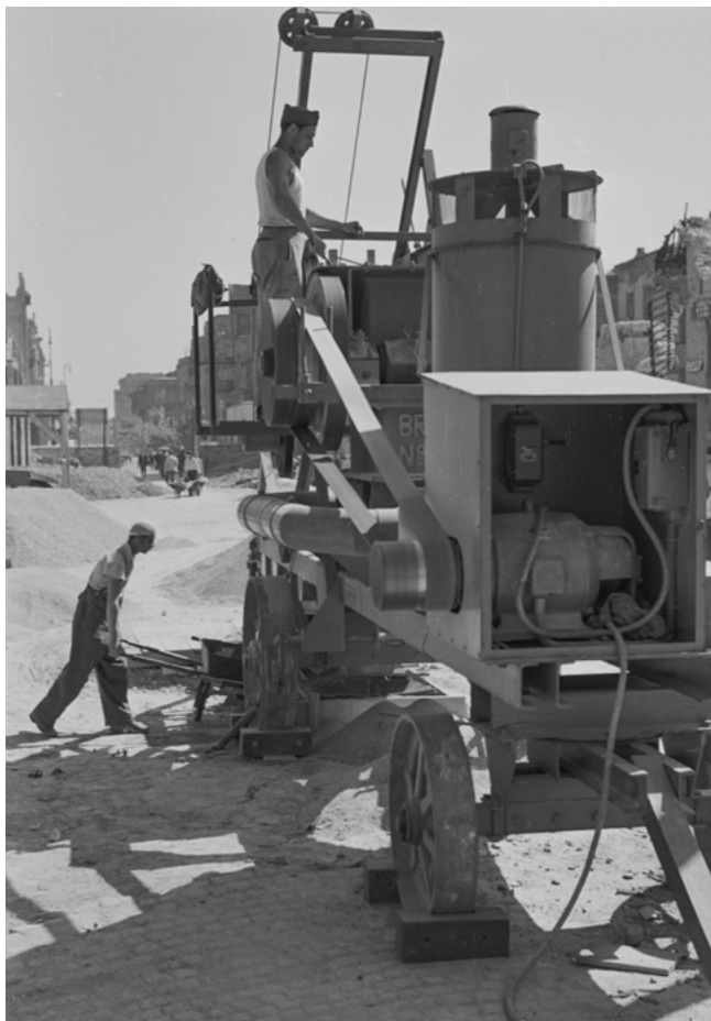
Reportaż z produkcji pustaków gruzobetonowych w Państwowym Przedsiębiorstwie Rozbiórki i Gospodarki Gruzem, 1947, fot. Alfred Funkiewicz, Muzeum Warszawy
