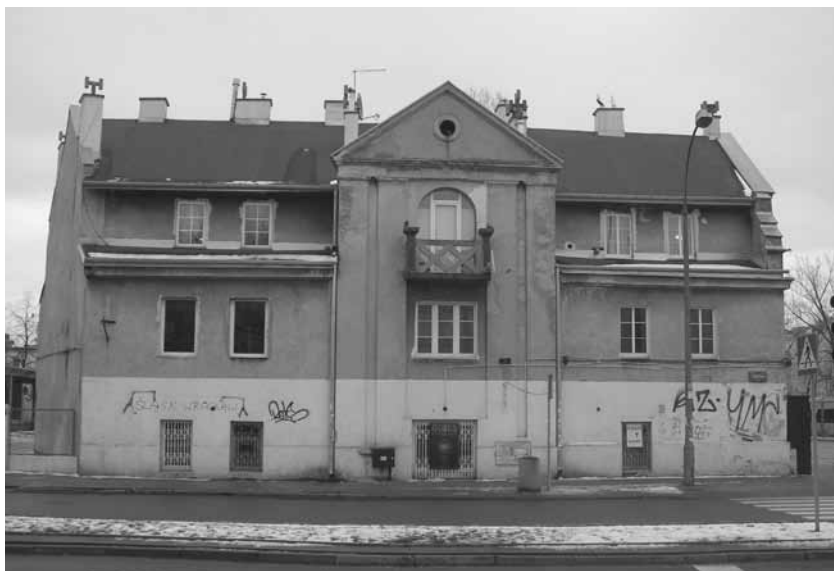
3 Widok tylnej części kamienicy przy ul. Grochowskiej 354, fot. Julian Borkowski / View of the rear of the tenement building at 354 Grochowska Street, photo: Julian Borkowski
