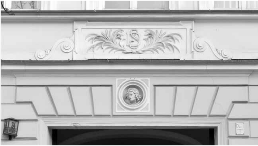
14. Dekoracje w kluczu i nadstawce portalu wjazdowego dawnej kamienicy czynszowej szpitala św. Rocha przy Krakowskim Przedmieściu nr 24 po odbudowie powojennej z monogramem wiązonym DS (Dom Studenta) i główką Aleksandra Wielkiego, 1845–1851, proj. Henryk Marconi, odbudowa i dekoracja 1947–1949, proj. Kazimierz Kamler, fot. M. Wardzyński, 2015 / Decorations at the entrance to the Saint Roch Hospital tenement house at 24 Krakowskie Przedmieście following postwar reconstruction, with the combined monogram DS ('Dom Studenta', Student House) and the head of Alexander the Great, 1845–1851, design Henryk Marconi, reconstruction and decoration 1947–1949, design Kazimierz Kamler, photo. M. Wardzyński, 2015
