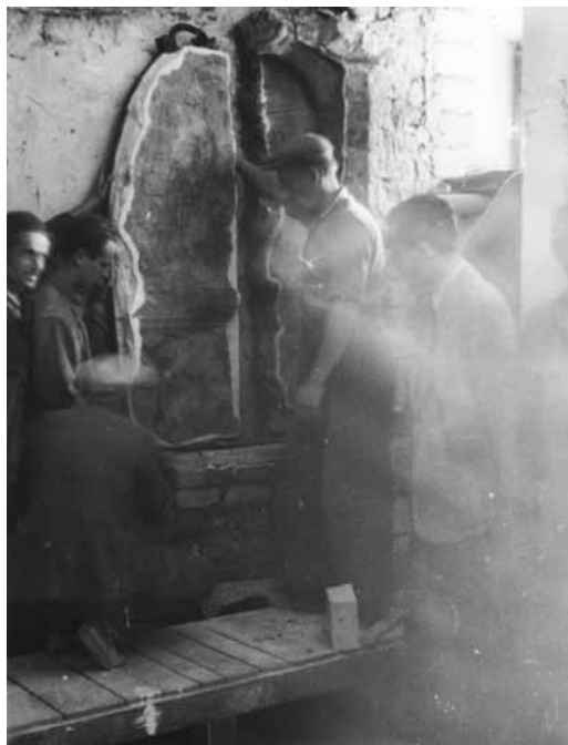
Fot. 3. Montaż przeniesionego malowidła w budynku przy Ryнку Staromiejskim 40, ze zbiorów Narodowego Instytutu Dziedzictwa, spuścizna ODZ, brak sygnatury / Photo. 3. Installation of the painting inside the building at 40 Rynek Starego Miasta, National Heritage Board of Poland collection, ODZ legacy, no number
