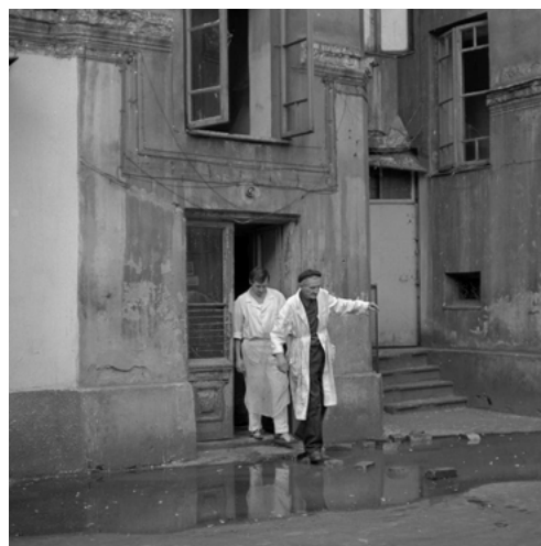
Podwórze kamienicy przy ulicy Środkowej 12, fot. Albert Krystyniak, 1973-75, Muzeum Warszawy, AN 103308
