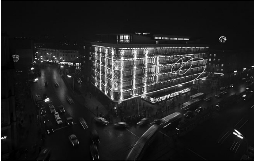
3. Skrzyżowanie Alej Jeruzolimskich z ul. Kruczą. Widoczny neon w formie zapętlonej strzałki dynamiczującej bryłą budynku CDT, fot. Z. Siemaszko, 1962–69 r. Źródło fotografii: NAC sygn. 51-259-2
